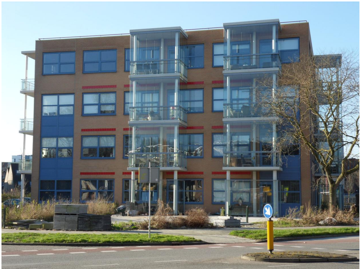
Balkons in Nieuwegein met hoge, transparante borstweringen. De bewoners kunnen ze open zetten.
